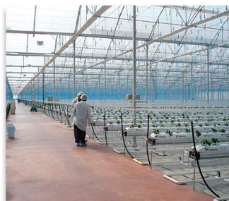
Denizli - TURQUÍA Invernadero APG96r PVC y Plástico APG96r - PVC and Plastic 11,5 Has.
